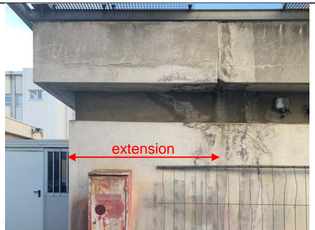
Fissure dans mur côté Nord
