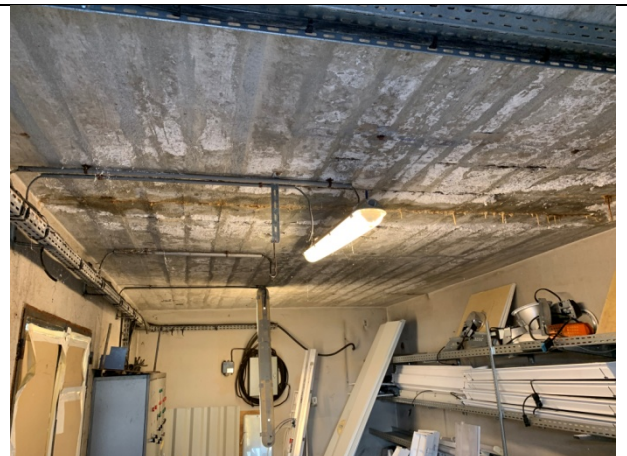
Infiltrations d'eau + aciers apparents
